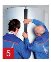
Une fois que la baguette couvre-joint a été posée, fermer le système d'isolation thermique au moyen de la deuxième barre de fermeture à crochet. Dans le cas d'une isolation thermique en 3 parties, répéter les 2 procédures précédentes.
