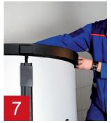
Positionner correctement le couvercle avec les creux pour les baguettes à crochets en haut du système d'isolation thermique.
