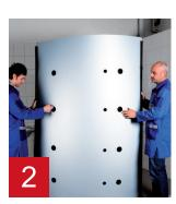
Remonter ensuite l'élément d'isolation thermique perforé, la partie non-tissée tournée vers l'intérieur, par-dessus les raccords.
