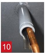
Montage des sondes à l'aide des ressorts fournis. Au total il est possible de monter 3 sondes par doigt de gant.
