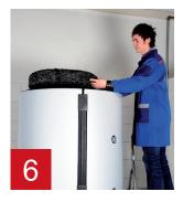
Placer l'isolation supérieure en haut de l'accumulateur, et la fixer en pressant légèrement.
