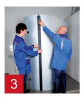
Encranter la pièce d'isolation thermique non perforée sur la barre de fermeture à crochet de la pièce d'isolation thermique déjà installée.
